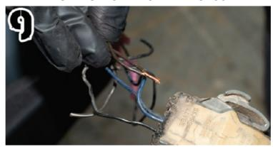
10. THEN TWIST BOTH BLUE WIRES TOGETHER CONNECT THE BLACK WIRE TO THE BLACK WIRE ON THE QUICK DISCONNECT.
