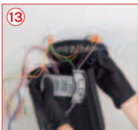
Conecte el cable NEUTRO (N) del driver al cable NEUTRO de su instalación. Una vez conectados, coloque la pieza **M**.
