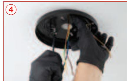
4 Coloque la pieza A y atornille los tornillos de fijación al falso techo.
