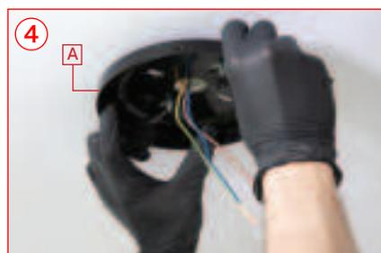
Coloque la pieza A haciendo coincidir sus agujeros con los tornillos D. Asegúrese de que los cables del techo pasan por el agujero central de la pieza A.
