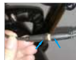
11. conecte el cable de fibra óptica (preste atención a la dirección de la flecha que debe corresponder)
