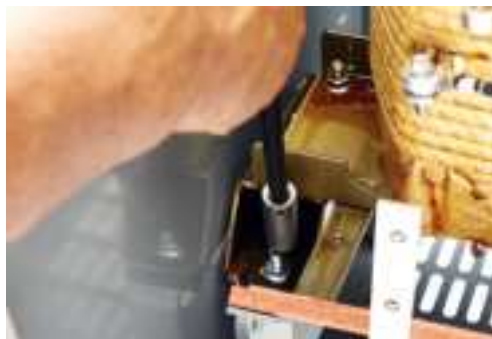
Figura 27 - Estilo del gabinete K: Pernos accesibles desde la parte frontal del transformador
