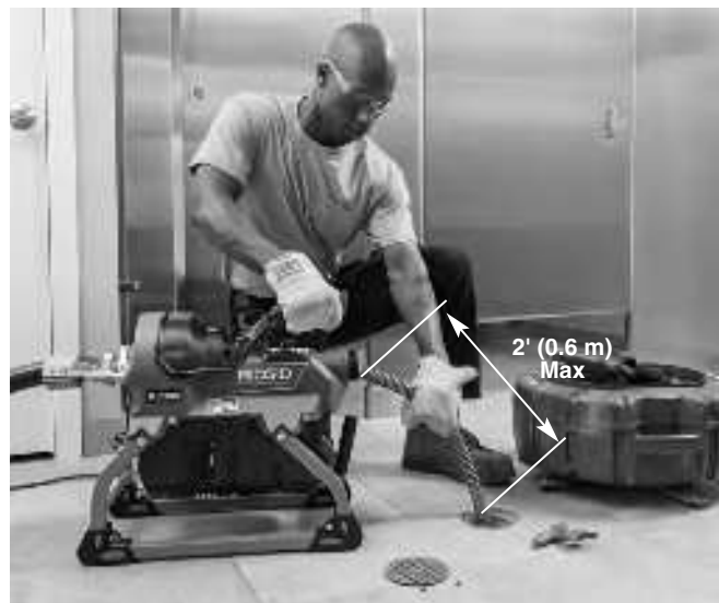
Figura 9 – El operario en posición de trabajo
