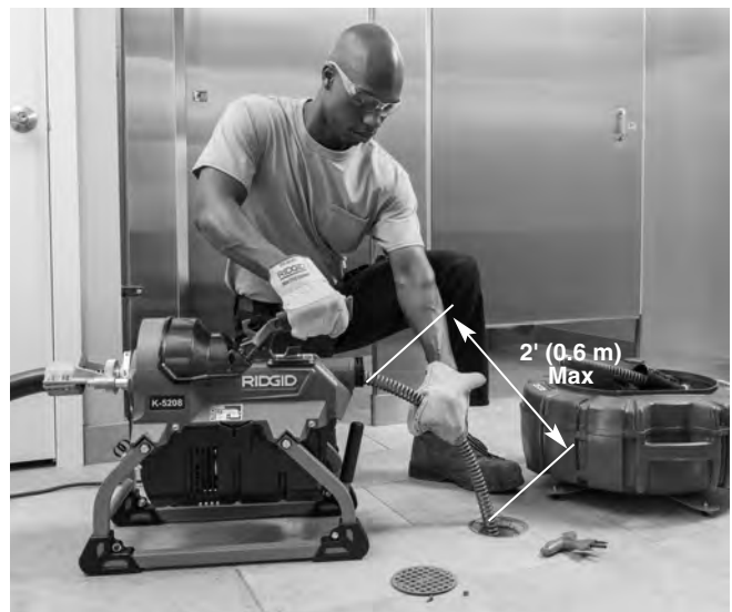
Figura 9 – El operario en posición de trabajo
