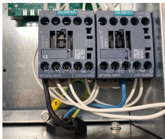
Figura 5. Conexión monofásica 230V 3L
