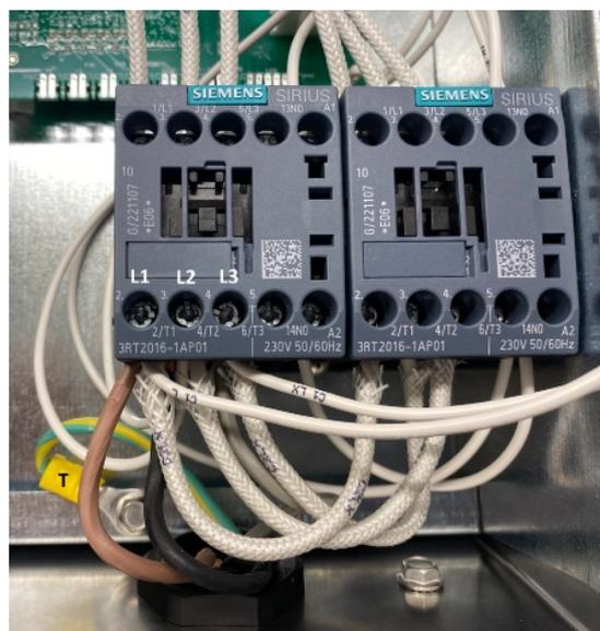
Figura 4. Conexión trifásica 230V 3L
