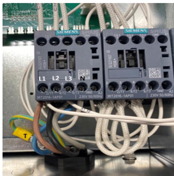
**Figura 3. Conexión trifásica 400V 3L+N**
