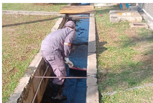
構内の水路の清掃
