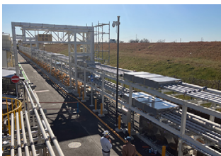
地下のトンネルに設置されていた排水配管を地上化し漏えいの検知や点検を強化
