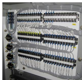
Figura 40: Interruptores MOC y TOC (tapa del interruptor MOC/TOC retirada para la foto)
