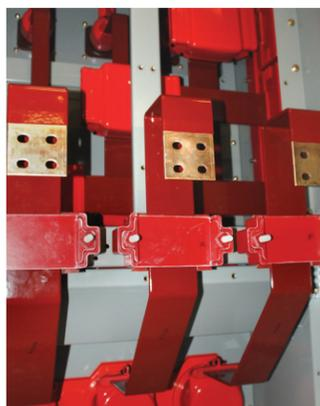
Figura 27: Compartimiento de terminación de cable típico (se quitaron las cubiertas del compartimiento de bus)
