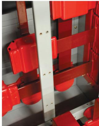
Figura 21: Bus principal con fundas aislantes instaladas (se quitaron las cubiertas del compartimiento del bus)
