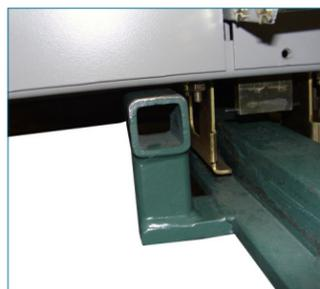
Figura 53: Alineación del montacargas manual con el interruptor automático (o bandeja desplegable de 63 kA)
