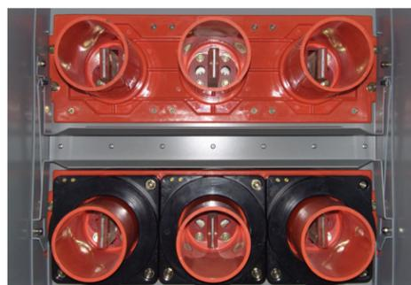
Figura 36: Transformadores de corriente tipo MD instalados en los seccionadores inferiores (barrera retirada para la foto)
