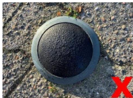
Abbildung 7 – Beispiel für eine nicht vorschriftsmäßige Anbringung
