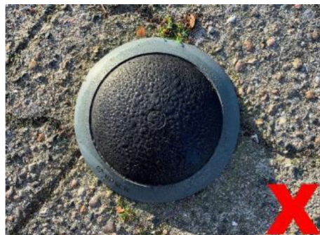
Εικόνα 7 Παράδειγμα μη συμμορφούμενης εγκατάστασης
