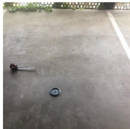
Abbildung 9 – Angebrachter Sensorsockel
