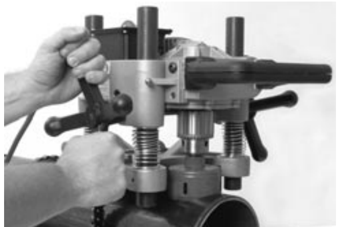
Figure 11 – Utilisation de la scie à cloche
