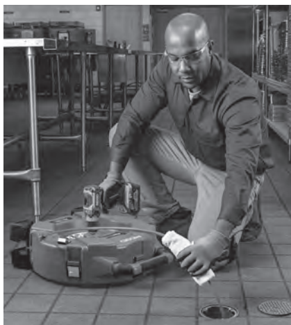
Abbildung 13 – Auftragen von Schmiermittel auf die Spiraleummantelung
