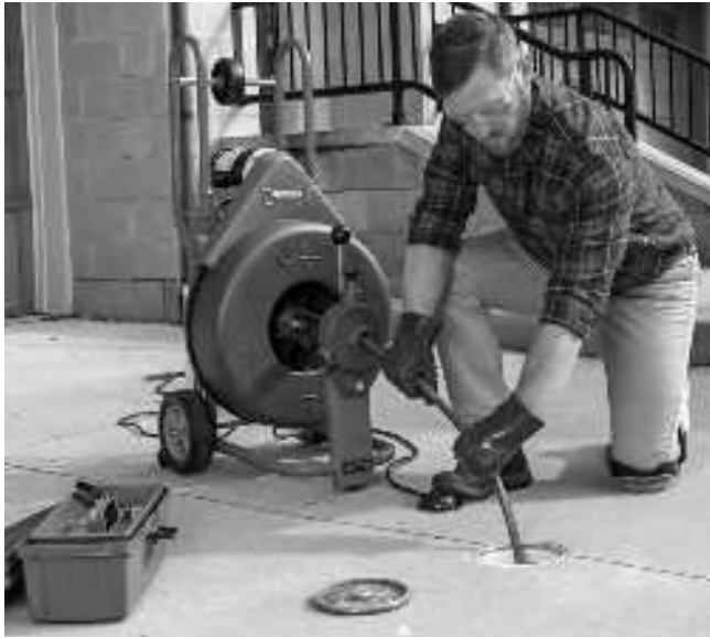
Figura 12 – El operario en posición correcta introduce el cable manualmente en el desagüe
