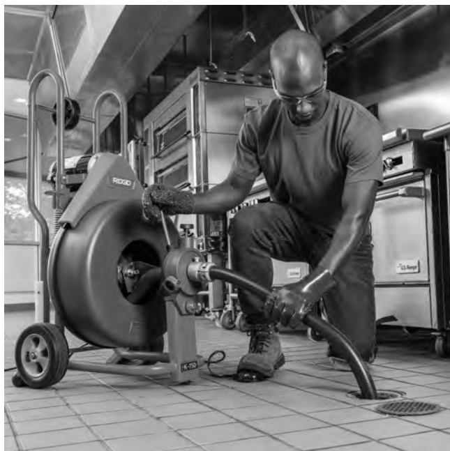
Figure 15 – Utilisation du dégorgeoir avec guide-câble
