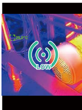
Alarme Temp Basse
