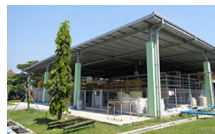
廃水処理施設（ヤマハ・ミュージカル・プロダクツ・インドネシア）
