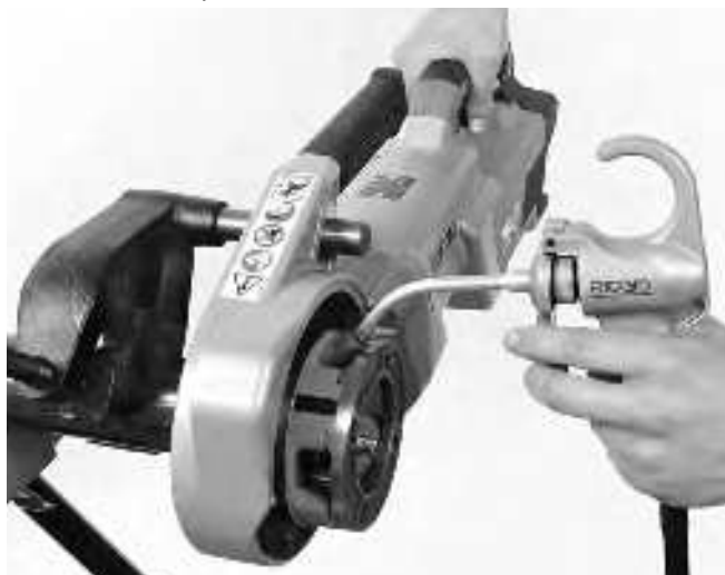
Figur 14 – Gevindskæring af rør
