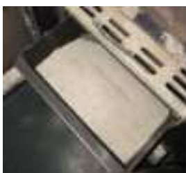
Beispiel eines verschmutzten Aschekastens
