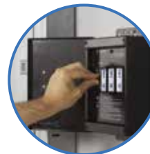
Step 2 Insert new module
