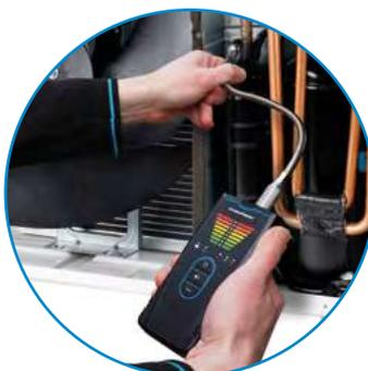
RILEVA LE PERDITE DI REFRIGERANTE DA UN'UNITÀ DI RAFFREDDAMENTO
