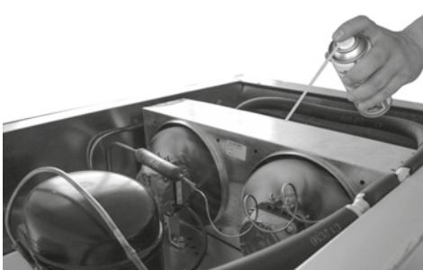
Dans les réfrigérateurs verticaux, la zone du condenseur se trouve sur la partie supérieure ou inférieure de l'armoire (selon les modèles). Nettoyez le condenseur avec un jet d'air comprimé et utilisez un aspirateur ou une brosse douce pour enlever la poussière de la zone motrice.
