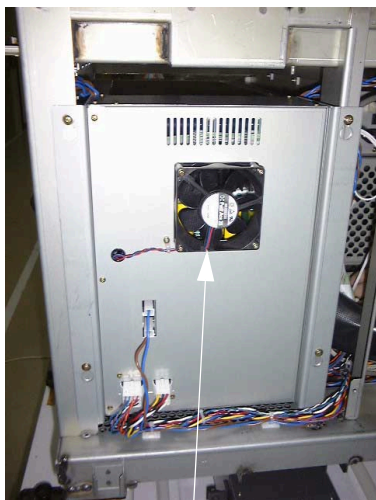
Fan for HV unit
