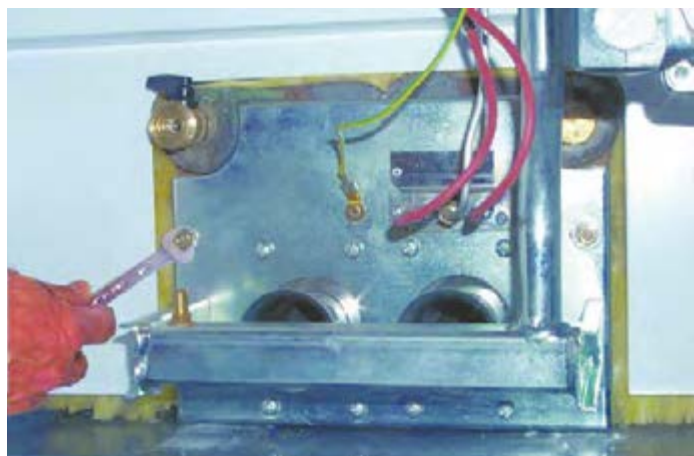
рис. 20 - Демонтаж горелок
