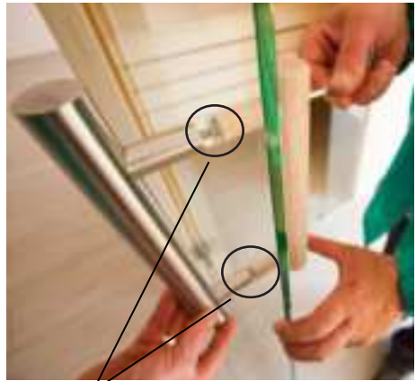
Kunststoff-Beilagscheiben bei Niro-Griff beilegen
