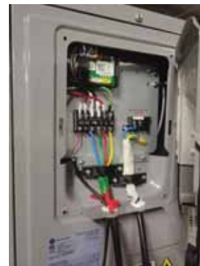
2. Deslice el panel hacia abajo para liberar los ganchos y empuje hacia fuera.
