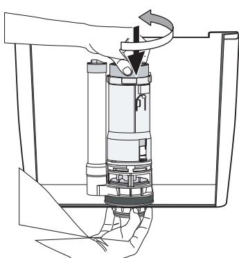
4a. Vzemite ogrodje izpustnega ventila in ga postavite na podstavek ter zaklenite tako, da ga zavrtite v smeri urinega kazalca.
