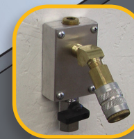
Hidden Mount Montaje Oculto Air line is inside wall La línea de aire está dentro de la pared
