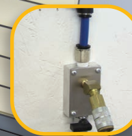
Surface Mount Montaje en Superficie Air line is mounted to wall La línea de aire está montada en la pared
