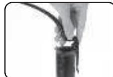
**B: ATTACHER LA CHAÎNE DU CLAPET.**
