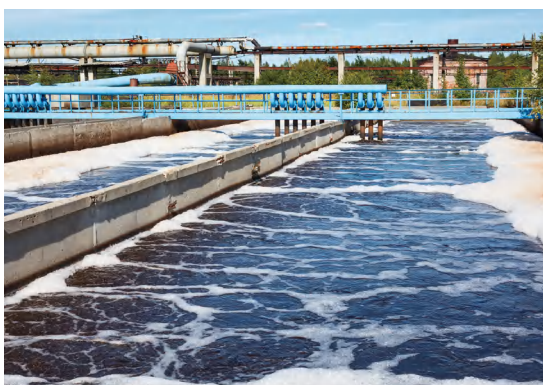
Tratamento de esgoto
