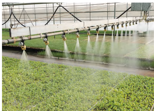
Bomba de irrigação
