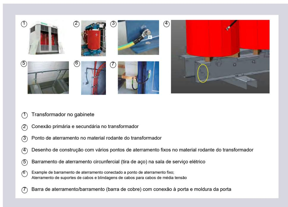
Fig. 1/2: Peças condutoras expostas em uma sala de serviço elétrico
