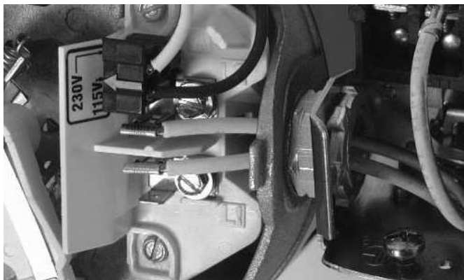
Figura 15 - Tensión configurada para 115 V, tipo ficha.
