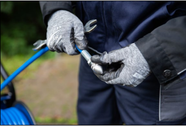
Abb. 7: Aufschrauben der Rohrreinigungsdüse
