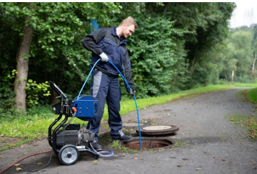
Abb. 11: Rohrreinigung mit Schlauch
