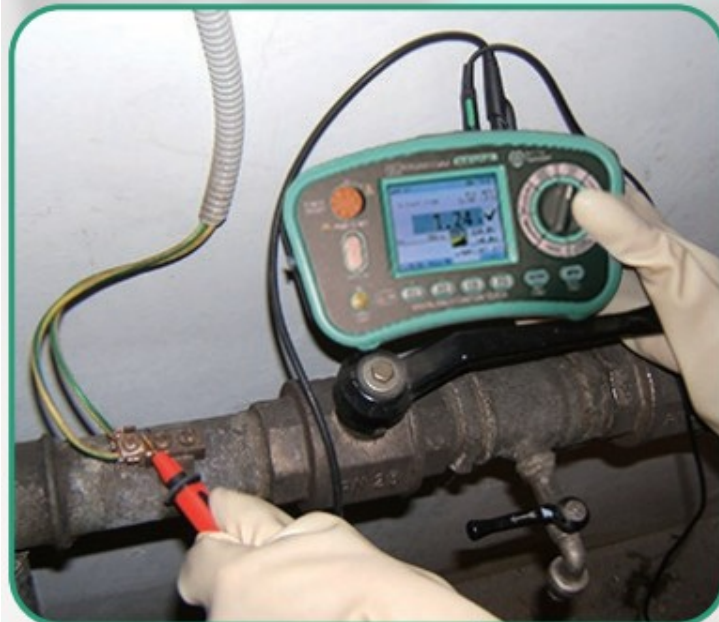
Continuity check of equipotential bonding
