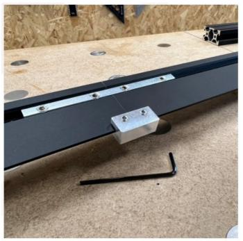
TAKING THE CONNECTOR BLOCK, YOU CAN SLIDE THIS ONTO THE EDGE, MAKING SURE ITS RIGHT IN THE MIDDLE OF THE JOIN.
