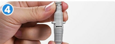
電源ケーブルを接続する
