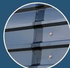
Guarnizioni impermeabili in nastro adesivo
