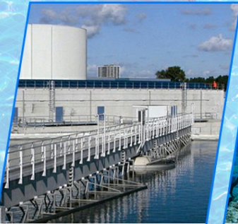
Trattamento dell'acqua potabile
