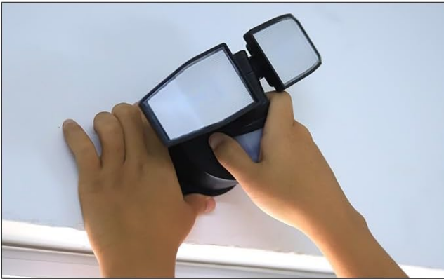
3. Strahler durch Drehen an Wandhalterung befestigen
