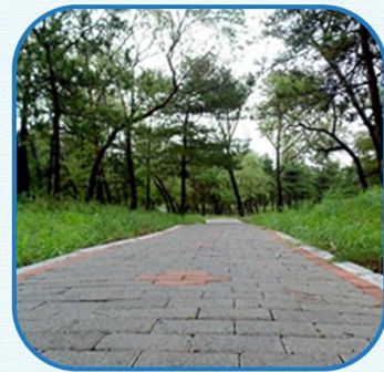
Suelo de ladrillo
