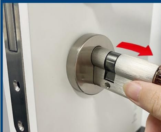
2. Rimuovere il vecchio cilindro della serratura.
