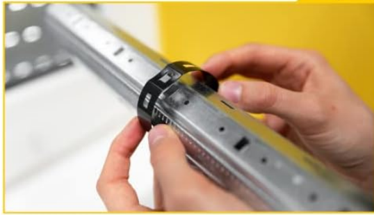
Die Einhängeklammer bündig zur Vierkantlochung der Rollladenwelle ausrichten, etwas ausdehnen und festklemmen
